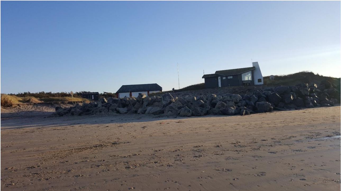
Figur 2 Billedet er optaget på samme dato som figur 1, viser de klippeblokke, der er udlagt nord for Nørlev Strandvej. Stenene drejer væk fra stranden ind mod klifoden til venstre på billedet. Sikringen er af samme type, som den sikring der er lavet syd for vejen. Parkeringspladsen ved Redningshuset bliver derved bevaret.
