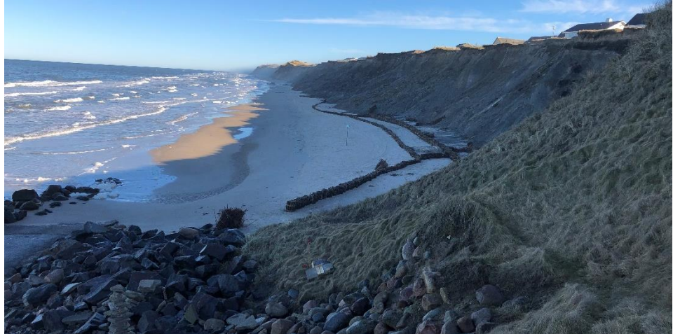
Figur 3.12 Strand nord for nedkørslen ved Nørre Lyngby
