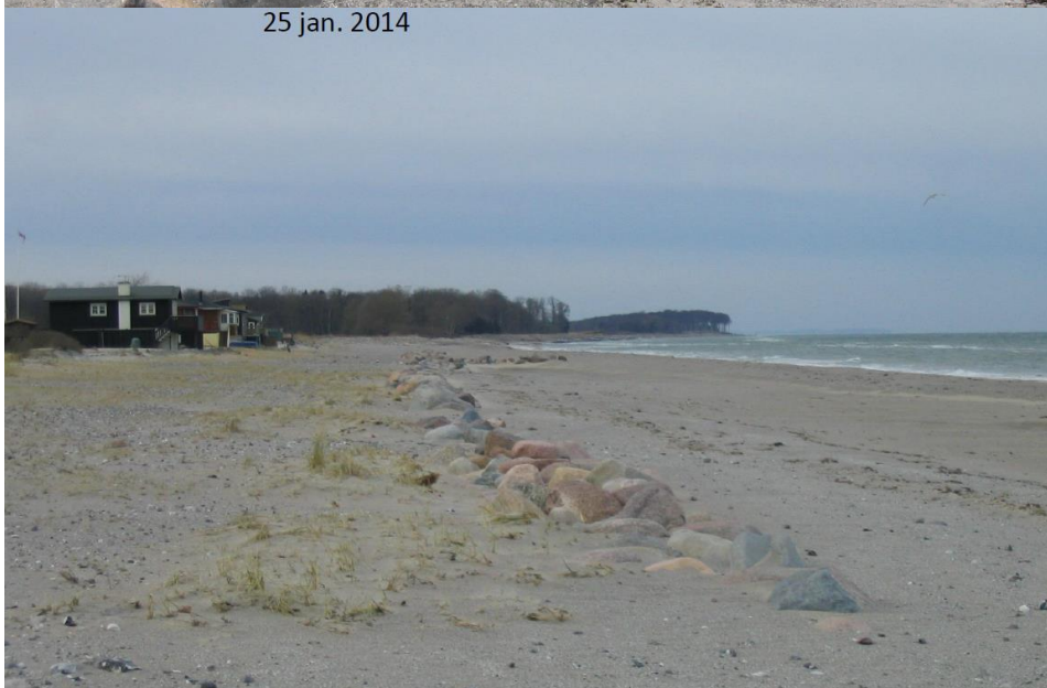
Figur 13.3: Effekt af løbende strandfodring på Nordfyn. 1999 før fodring, maj 2012 før stormen Bodil, januar 2014 efter stormen Bodil
