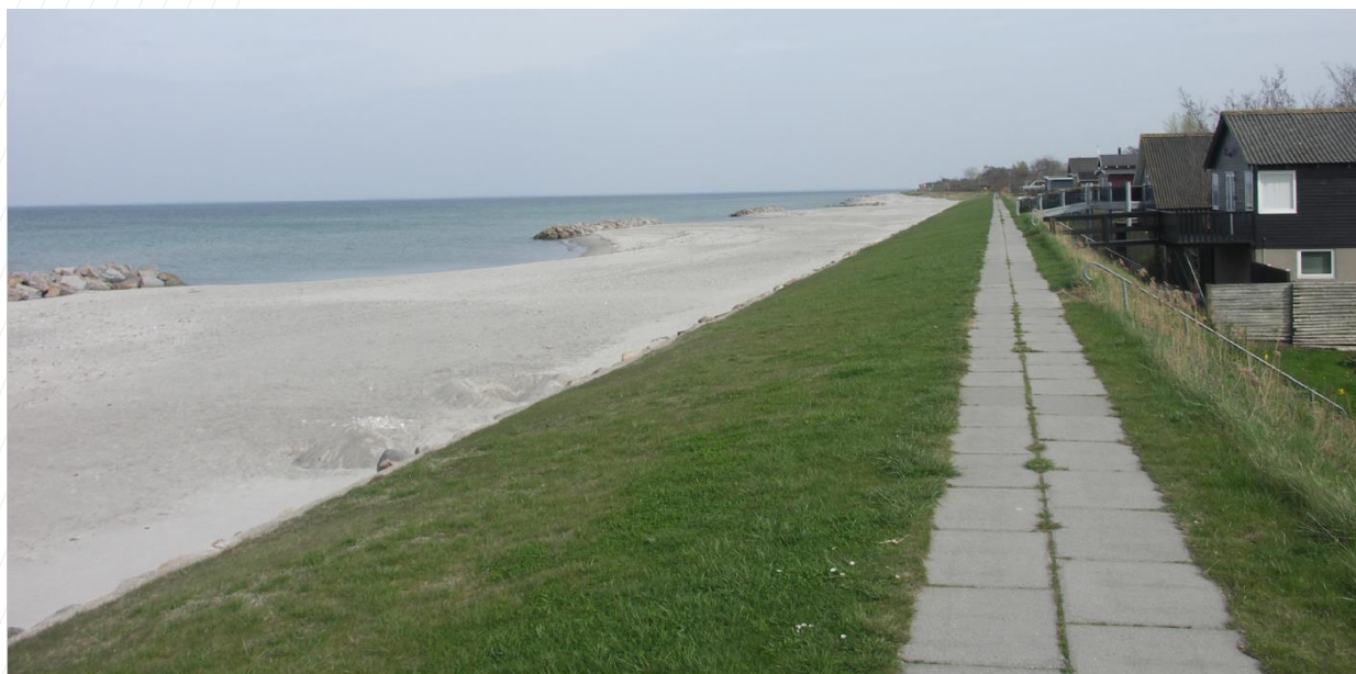
Figur 13.2: Strækning med nye bølgebrydere og skråningsbeskyttelse samt vedligeholdelsesstrandfodring ved Tørresø, Nordfyn
