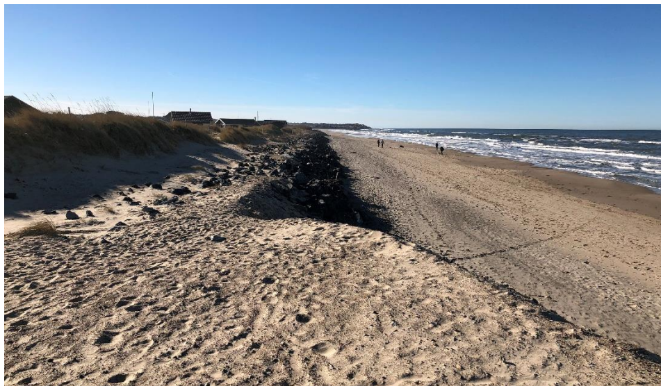
Figur 3.24 Ny skråningsbeskyttelse sydvest for nedkørslen ved Nørlev Strand
